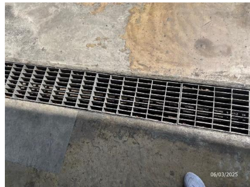
รูปที่ 70 ตะแกรงครอบท่อระบายน้ำ
