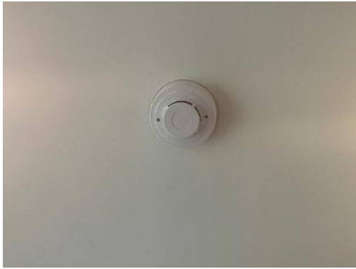
รูปที่ 85 เครื่องตรวจจับควัน (Smoke Detector)
