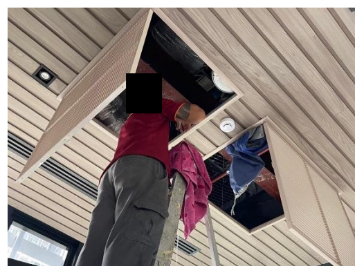
รูปที่ 78 การล้างเครื่องปรับอากาศแบบเต็มระบบ
