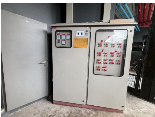
รูปที่ 27 ตู้ควบคุมสำหรับระบบบำบัดน้ำเสีย
