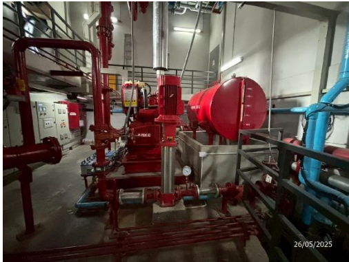
รูปที่ 79 เครื่องสูบน้ำดับเพลิง (Fire pump)
