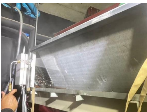
รูปที่ 77 การล้างแผ่นกรองอากาศของเครื่องปรับอากาศ
