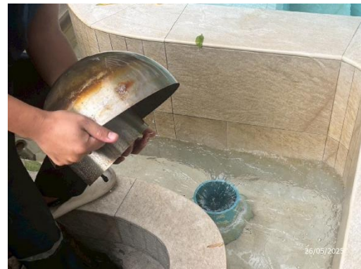
รูปที่ 54 รางระบายน้ำล้นมีฝาปิดรอบสระว่ายน้ำ
