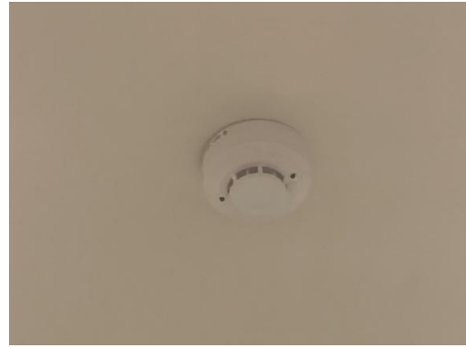
รูปที่ 86 เครื่องจับความร้อน (Heat Detector)
